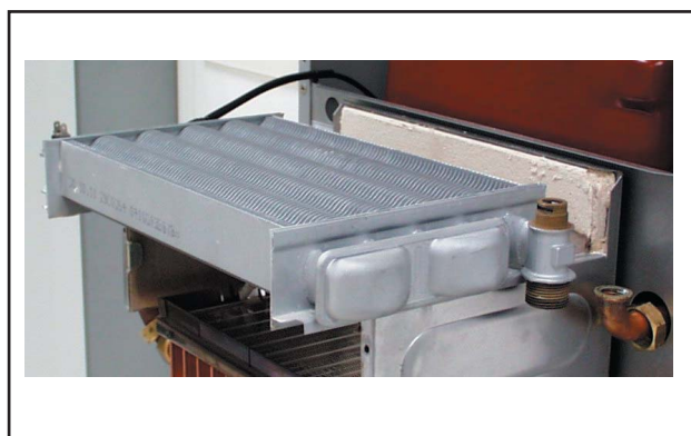
Pav. Šildymo sistemos kaitrinio bloko šilumokaičio demontavimas (atjungus)
