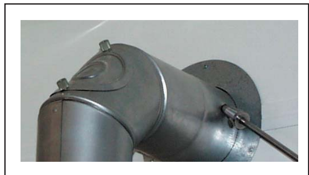
Pav. Degimo produktų matavimai GU-2E-S atveju
