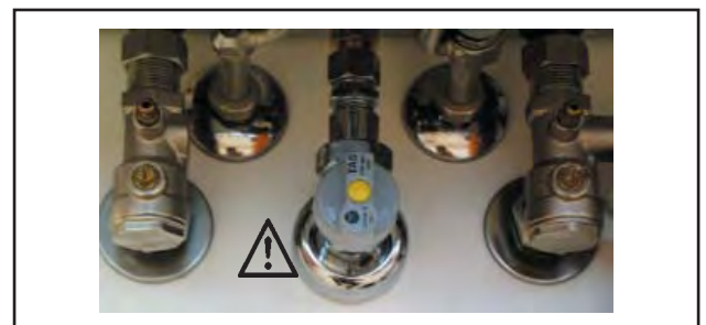
Pav. Dujų kontūro prijungimo mazgai pažymėti ženklu, kuris įspėja apie apsinuodijimo ir sprogo pavojų dujų nutekėjimo atveju.
