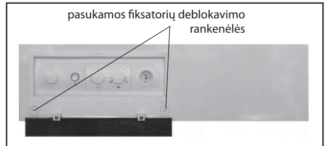
Pav. Pasukamų fiksatorių deblokavimo rankenėlių deblokavimas
