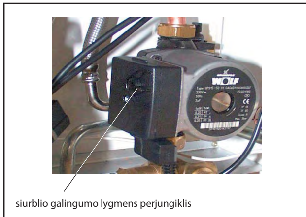
Pav. Šildymo prietaiso kontūro siurblio perjungiklis
