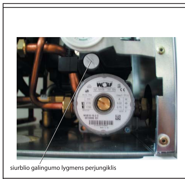
Pav. Šilto vandens paruošimo bakelio šildymo kontūro siurblio perjungiklis
