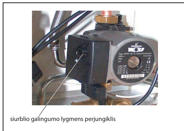
Pav. Šildymo prietaiso kontūro siurblio perjungiklis
