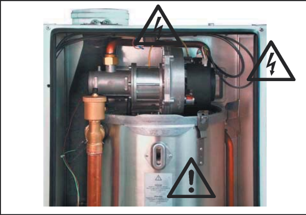
Pav. Uždegimo transformatorius, aukštos įtampos uždegantis elektrodas, degimo kamera pažymėti ženklu „Pavojinga gyvybei įtampa“ ir ženklu, kuris įspėja apie apsideginimo pavojų, prisilietus prie įkaitusių konstrukcijos mazgų.
