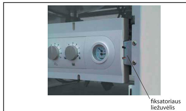
Pav. Nuspauskite fiksatoriaus liežuvėlį
