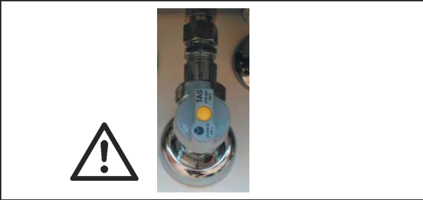
Pav. Dujų kontūro prijungimo atvadas pažymėtas ženklu, kuris įspėja apie apsinuodijimo ir sprogimo pavojų dujų nutekėjimo atveju.
