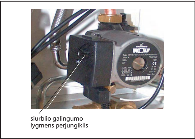
Pav. Šildymo prietaiso kontūro siurblio trijų padėčių perjungiklis
