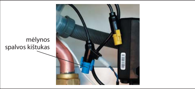
Pav. Mėlynos spalvos kištukas šilto vandens paruošimo bakelio temperatūros davikliui prijungti
