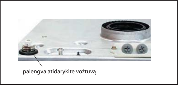
Pav. Vožtuvas greitam oro išleidimui „rankiniu būdu“
